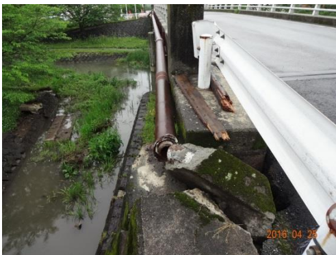
写真9 橋が右ずれ
