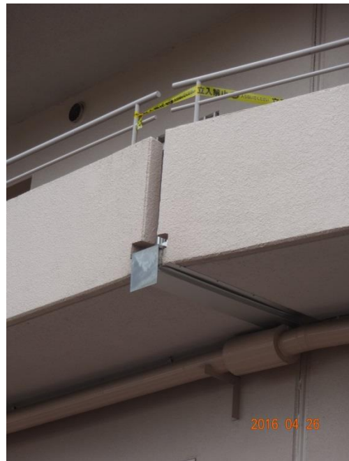
写真4 エクスパンションのずれ
