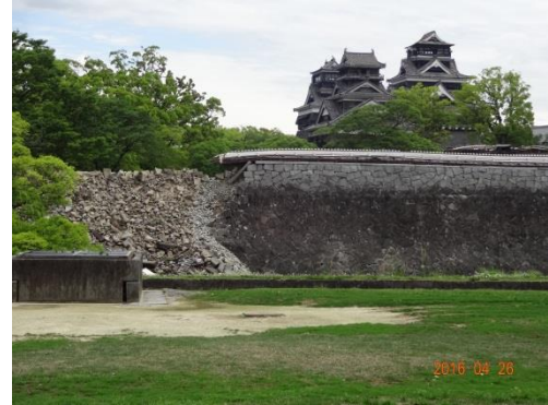
写真8 熊本城の被害
