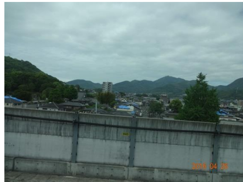
写真2 棟瓦の被害が顕著
