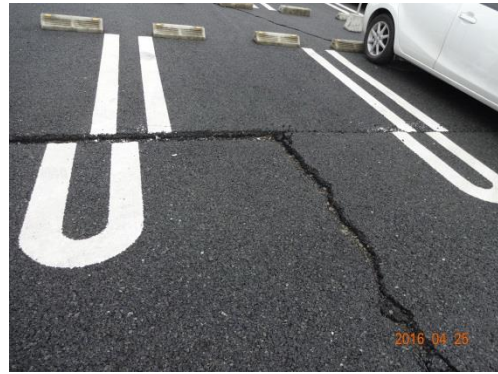
写真4 病院駐車場の右ずれ
