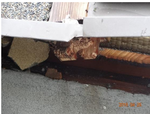
写真7 柱の腐食
