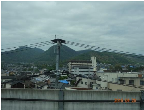
写真1 郊外丘陵住宅の被害
