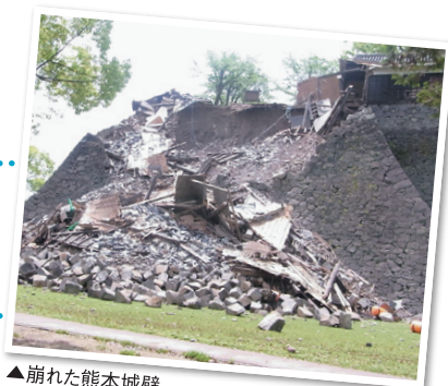
▲崩れた熊本城壁
