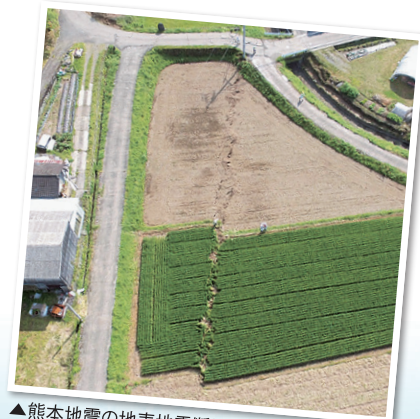
▲熊本地震の地表地震断層
