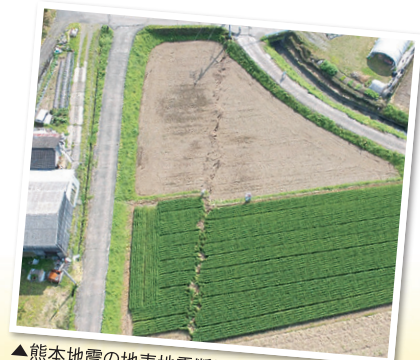
▲熊本地震の地表地震断層
